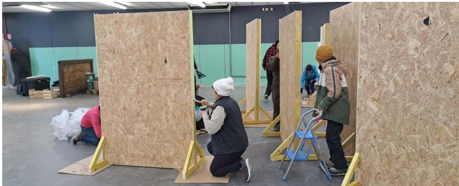
Lors du premier chantier participatif, réalisation de module de séparation utilisés dans la salle partagée, ouverte à tous en location.
