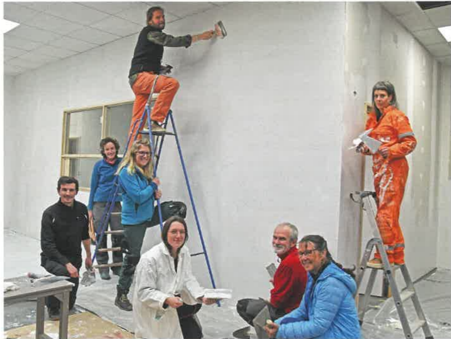
Toute l'équipe de la Société coopérative s'affaire aux différents travaux pour que les locaux soient opérationnels à la mi-avril.
